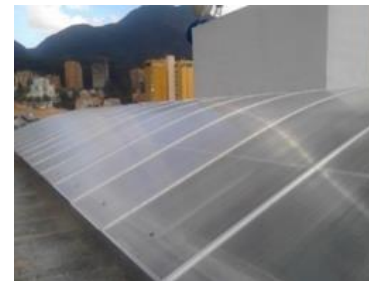
CUBIERTA EN POLICARBONATO
