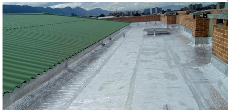
C.R. Almería Real – cubierta en fibrocemento e impermeabilización
