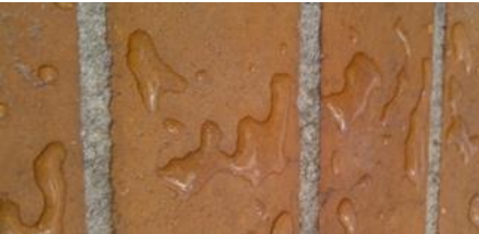
Corrección de fisuras en ladrillo a la vista y en áreas de concreto
