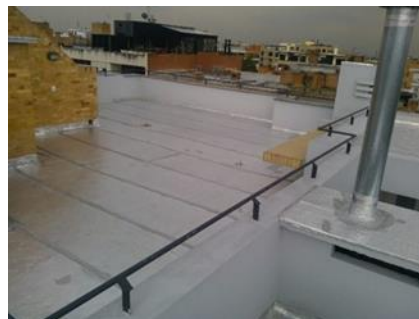
C.R. Almería Real – cubierta en fibrocemento e impermeabilización
