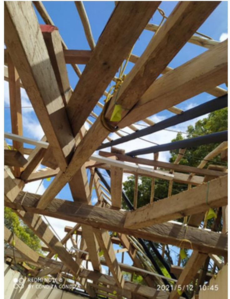
Estructura para cubierta de Teja de barro
