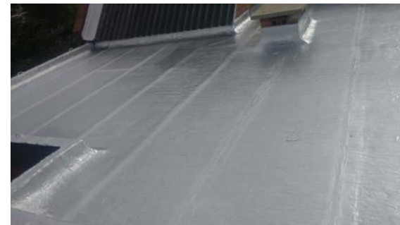
C.R. Almería Real – cubierta en fibrocemento e impermeabilización
