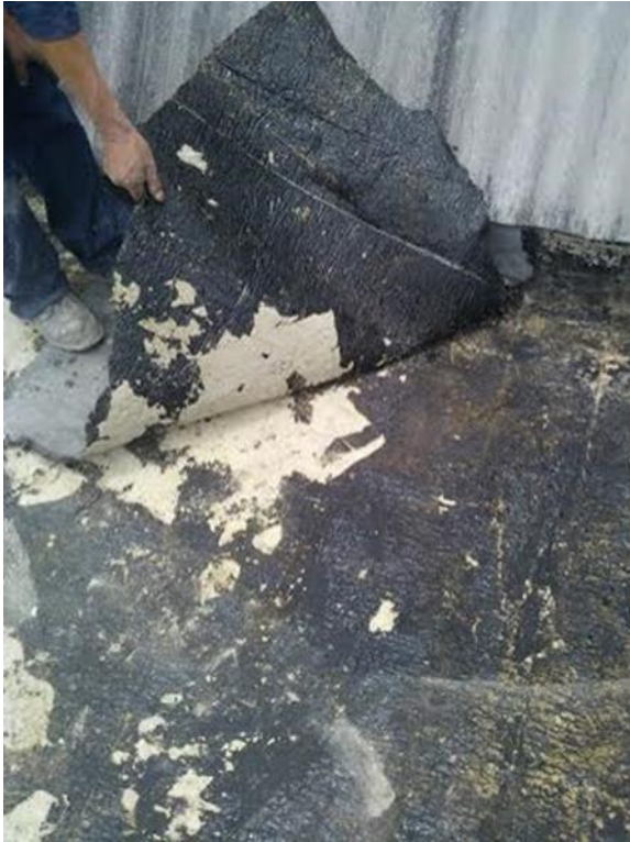
Retiro de manto existente
