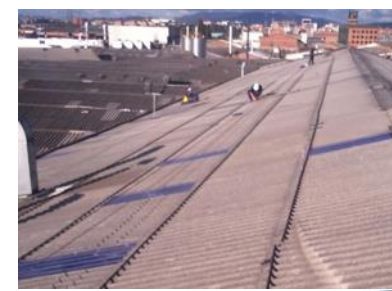
REPARACION CUBIERTA FIBROCEMENTO
