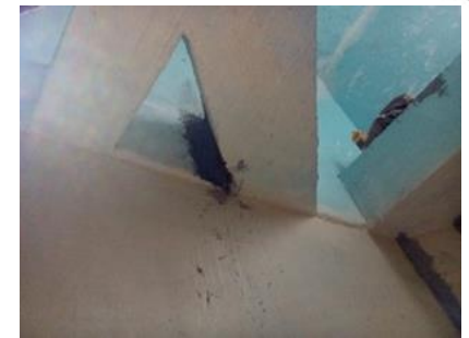
Proceso de aplicación de poliurea
