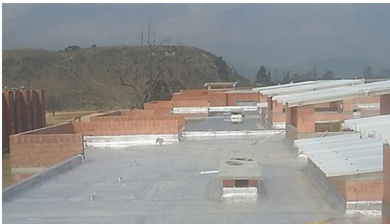
Hogares Soacha - Constructora Apiros
